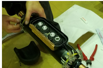
※スクリー方式採用6kV直線接続材CKM（JCAA K1301準拠試験合格品）
